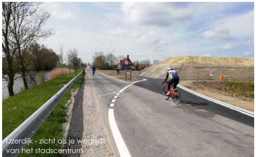
IJzerdijk - zicht richting stadscentrum
